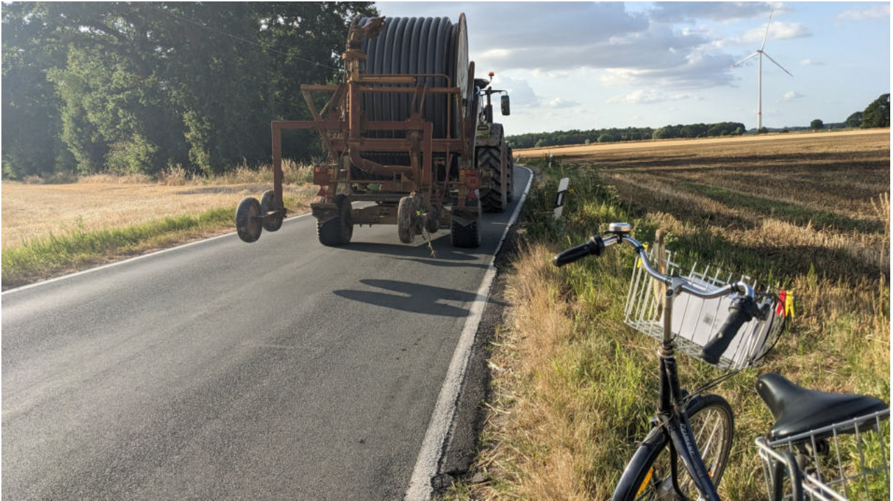
Radwegebau an Landesstraßen
